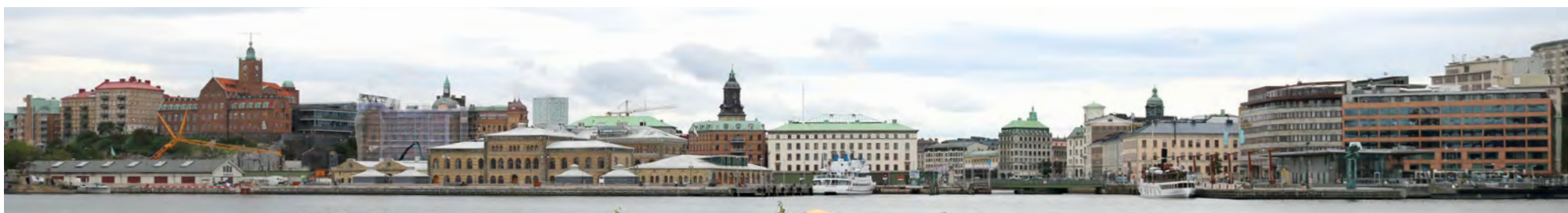
Stadens front mot älven präglas av 1800-talets hamnverksamhet och bebyggelse.
